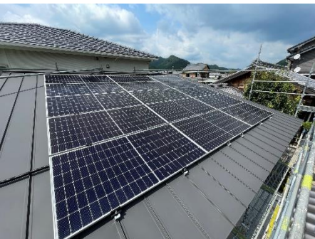
新築戸建て住宅
